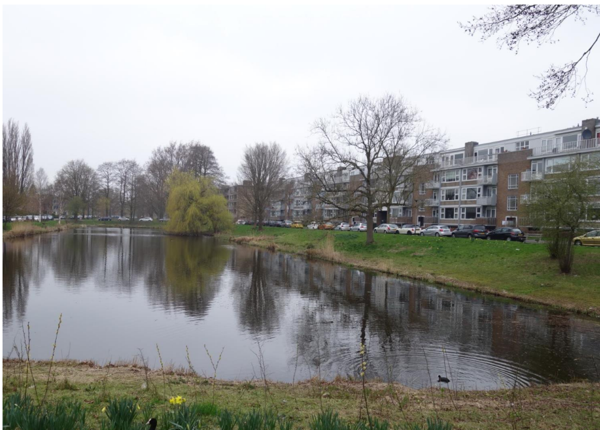
Figuur 43. De Hora Siccamasingel is een bijzonder stedenbouwkundig ensemble vanwege de samenhang in stedenbouwkundige opzet en ruimtelijke karakteristieken.
