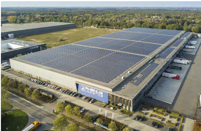
Zonnepark op platte daken, onder andere van bedrijventerreinen en winkelcentra (referentie distributiecentrum bij Eindhoven).
